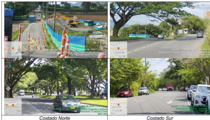
Fotografías 1 a 4. Estado actual del área de intervención
